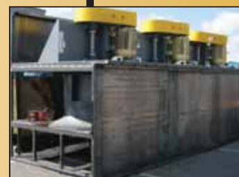
Factory-assembled fan modules
